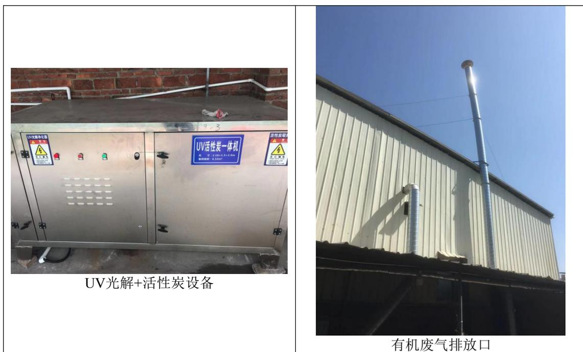
图 4.1-2 项目废气治理系统图
